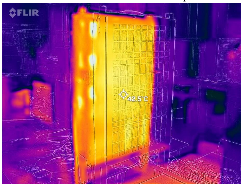
Fig. 13. Spectrul de temperaturi pe suprafața panoului fotovoltaic
